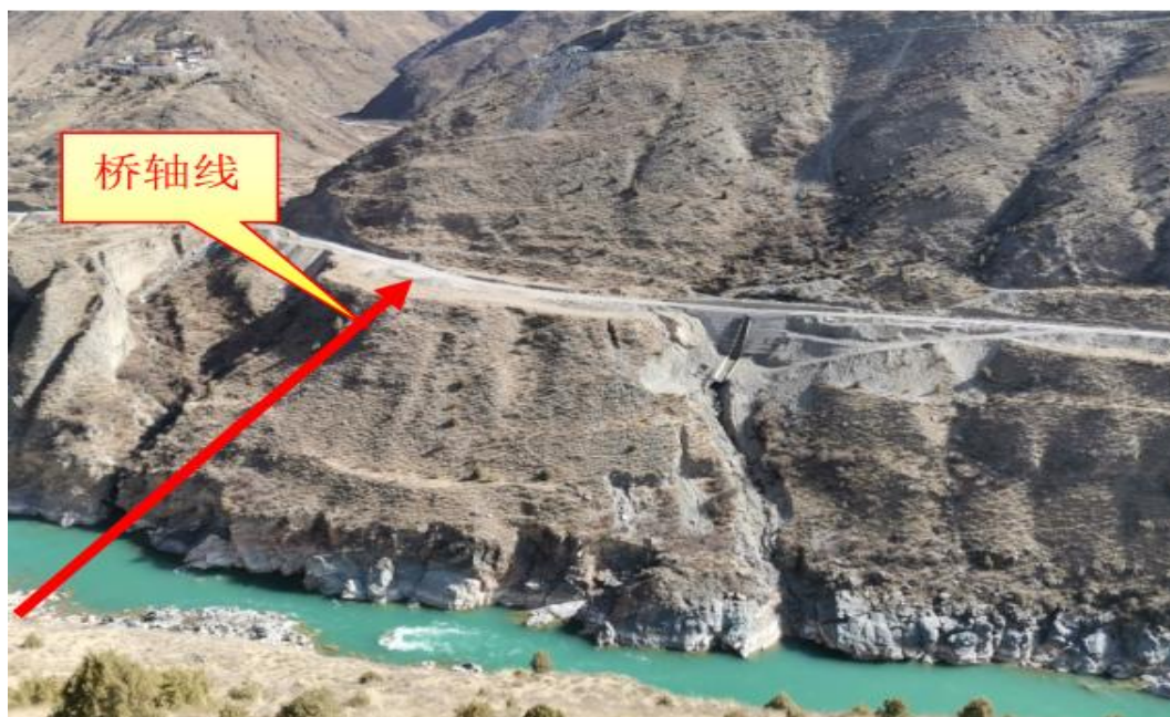
图 1.2-1 桥位现场照片
