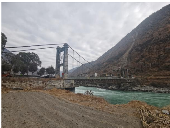
K20+630 德威大桥
