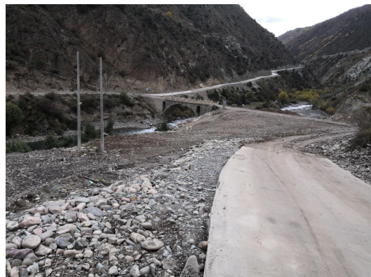
施工便道远离居民区
