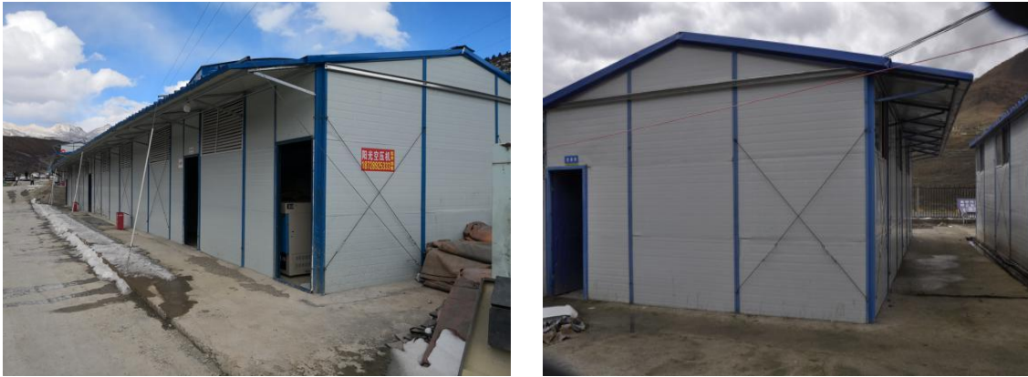
施工营地卫生间
