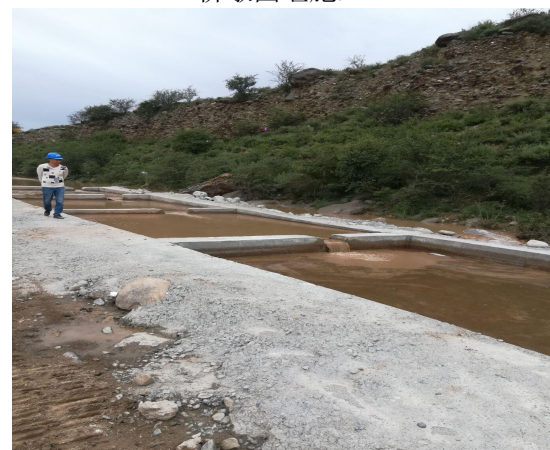
施工场地沉淀池
