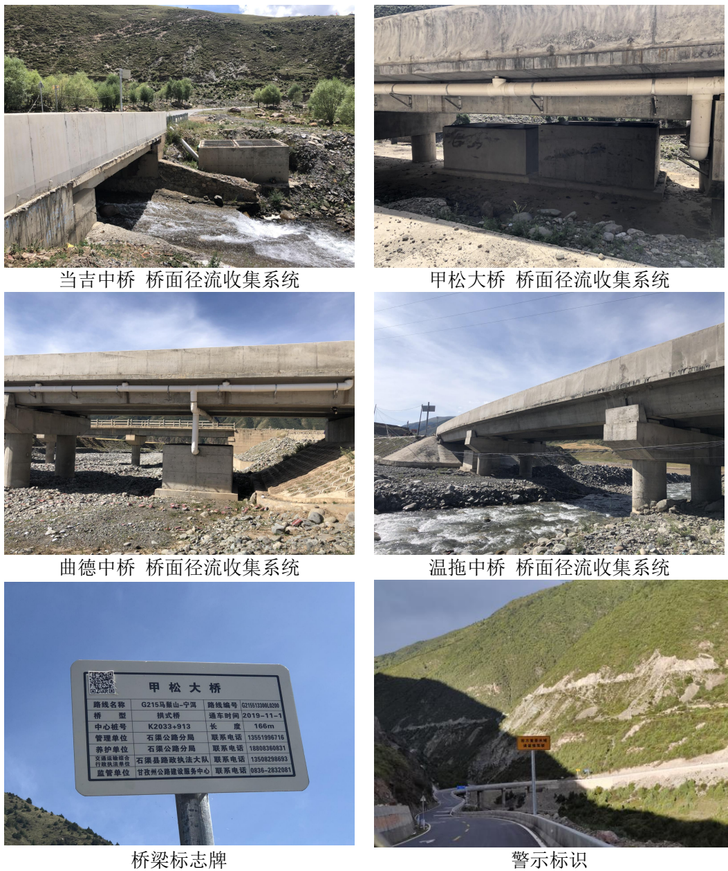
图 7.3-1 项目沿线路面、桥梁径流收集措施和警示标识现场照片
