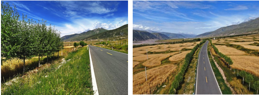
公路路肩绿化恢复
