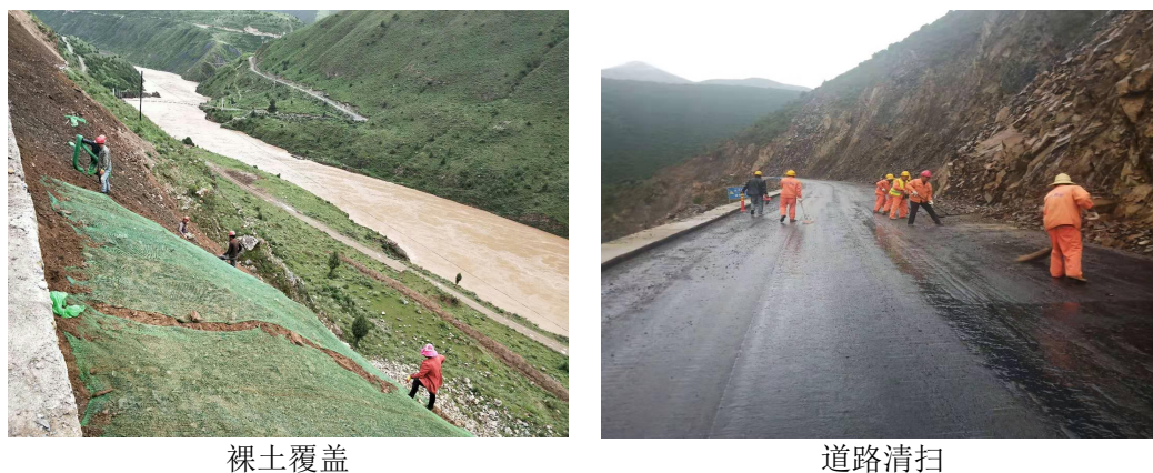
图 8.1-1 施工期采取的环境空气保护措施
