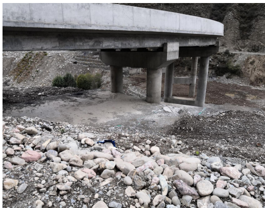
枯水期桥梁施工
