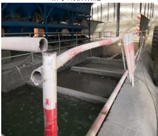
拌和站沉淀池
