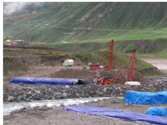
桥墩围堰施工
